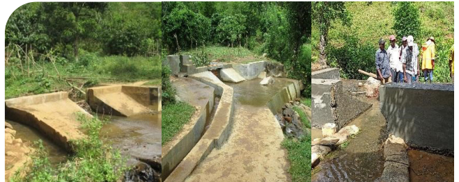
► Réhabilitation de canaux : Mahatsara, Vavatenina, Analanjirofo (avant, pendant et après travaux.)
