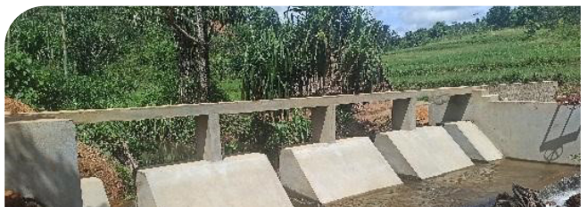
► Réhabilitation d'un barrage à Ampasimbola, Soanierana Ivongo, Analanjirofo (après travaux)
