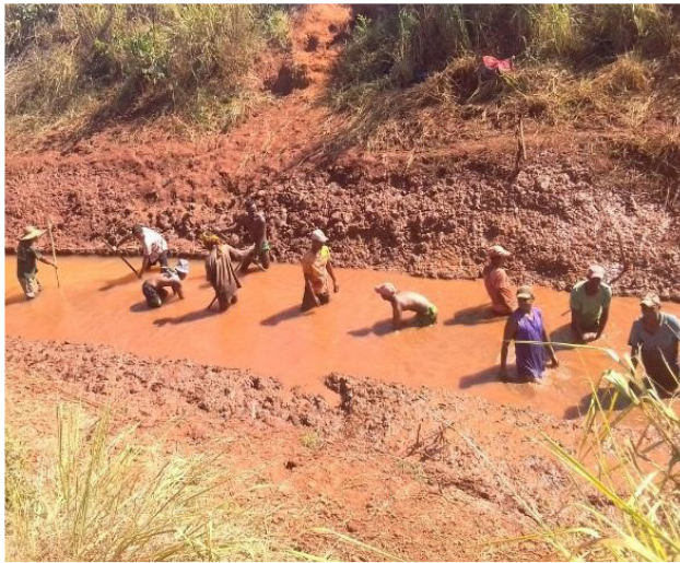
► Entretien du réseau d'irrigation du périmètre de Demoka rive Droite – Curage, Melaky
