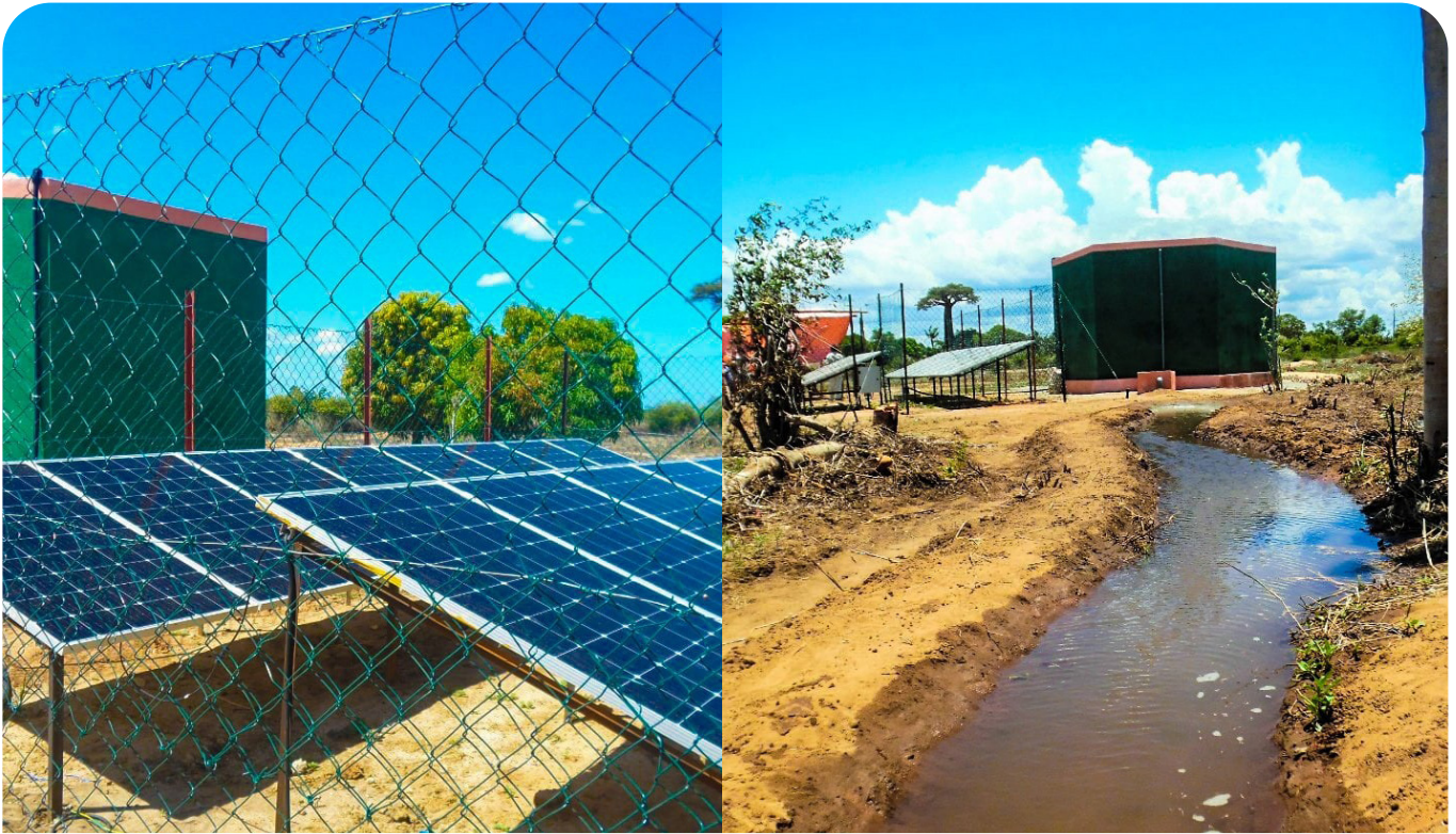
► 12 janvier 2021 : Construction d'un forage alimenté par énergie solaire dans la commune rurale de Bemanonga, Région Menabe.
